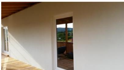
Wandverkleidung mit WDVS System 100 mm verklebt
